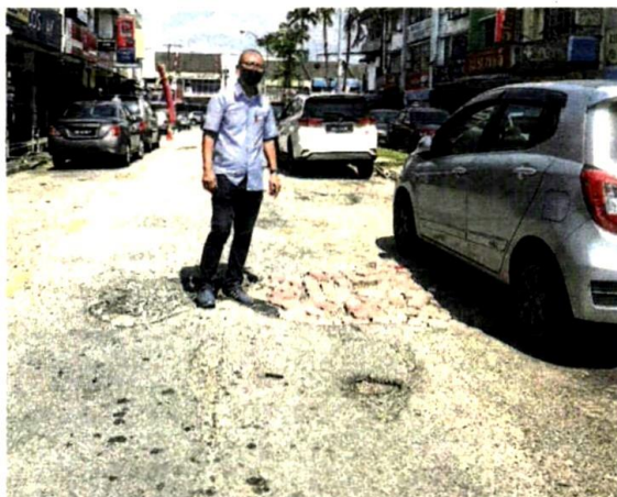
■神建华巡视陈明再也新商区了解路洞情况。
